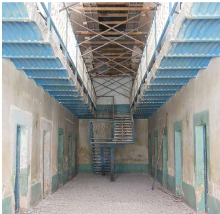
Figura 9. Interior de un pabellón del anexo sin intervenir. Fotografía: Equipo constructor del museo Leonora Carrington
