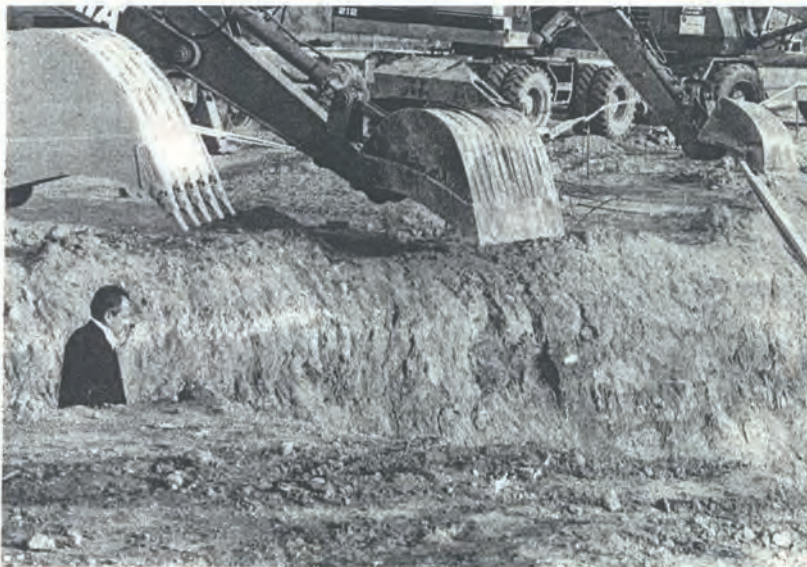
El oficiante desciende hacia el foso ante el recogimiento de las excavadoras
